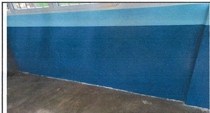
Foto 3: Reparacion de repello y cernido en muro de mamposteria con aplicacion de acabado uniforme
