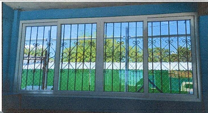
Foto 1: sustitucion de ventanas; sistema de apertura: corredizas, perfil blanco estandar, material de marco: pvc Material de la ventana: Vidrio sellado perimetral
