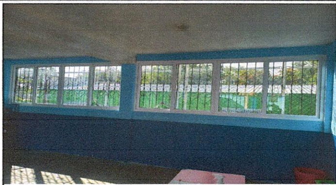
Foto 2: preparacion de la superficie y aplicacion de pintura a dos manos, en paredes interiores y exteriores del establecimiento
